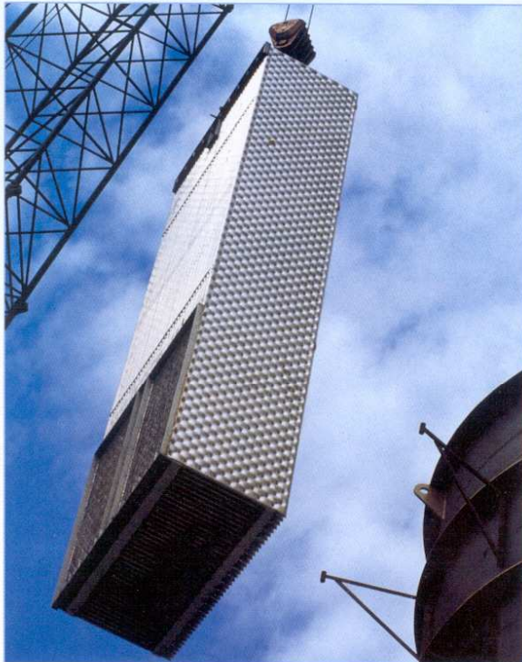
Ein Wärmeaustauschmodul für einen Platten-Fallfilmverdampfer wird eingebracht.
